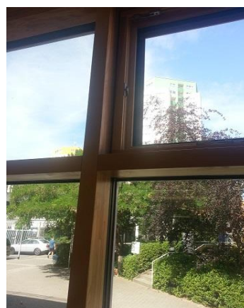
Flächenbündig Aussen somit dicht! Innenansicht
