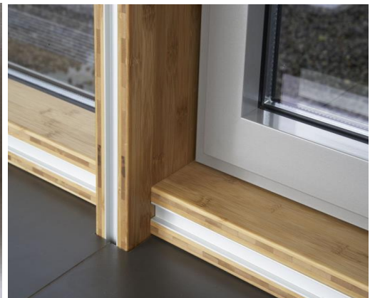
Pfosten/Riegel aus Bambus Innenansicht
